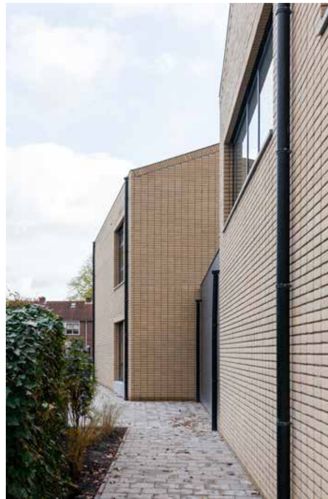
Aan de achterzijde van het gebouw is de hoekverdraaiing goed zichtbaar
